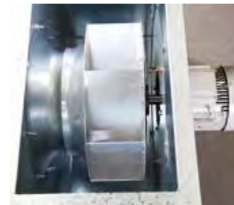
DIRECT DRIVE CENTRIFUGAL FAN
