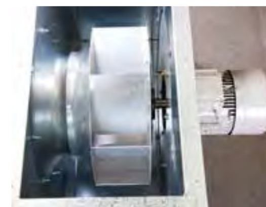
DIRECT DRIVE CENTRIFUGAL FAN
